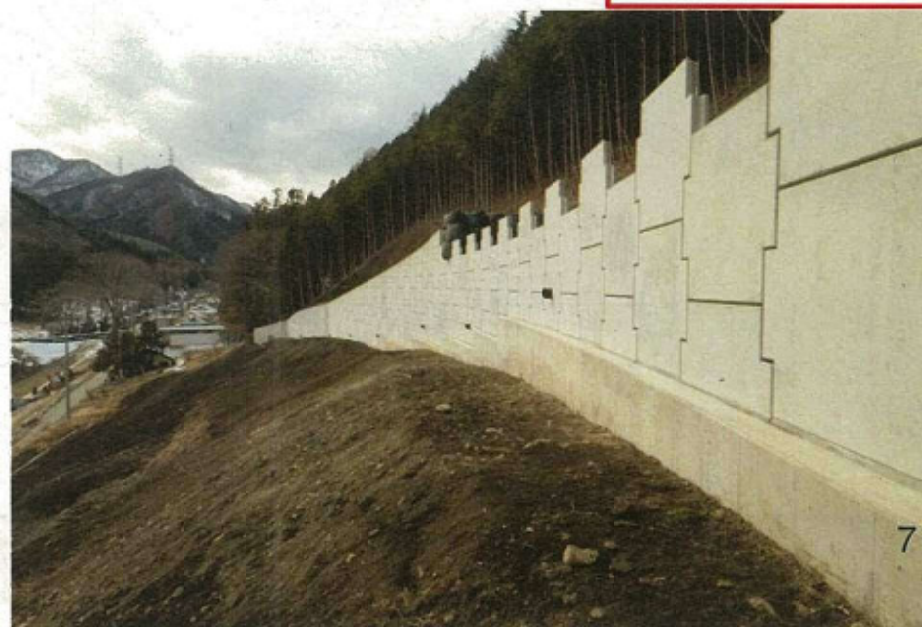
補強土壁工
