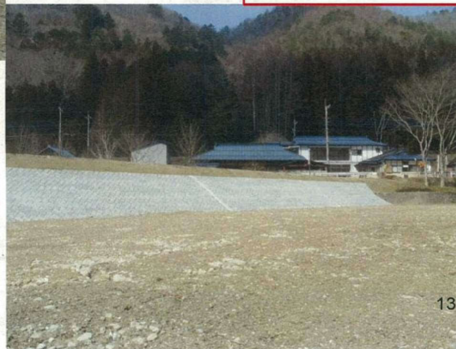
土砂置場完成(男鹿川)
