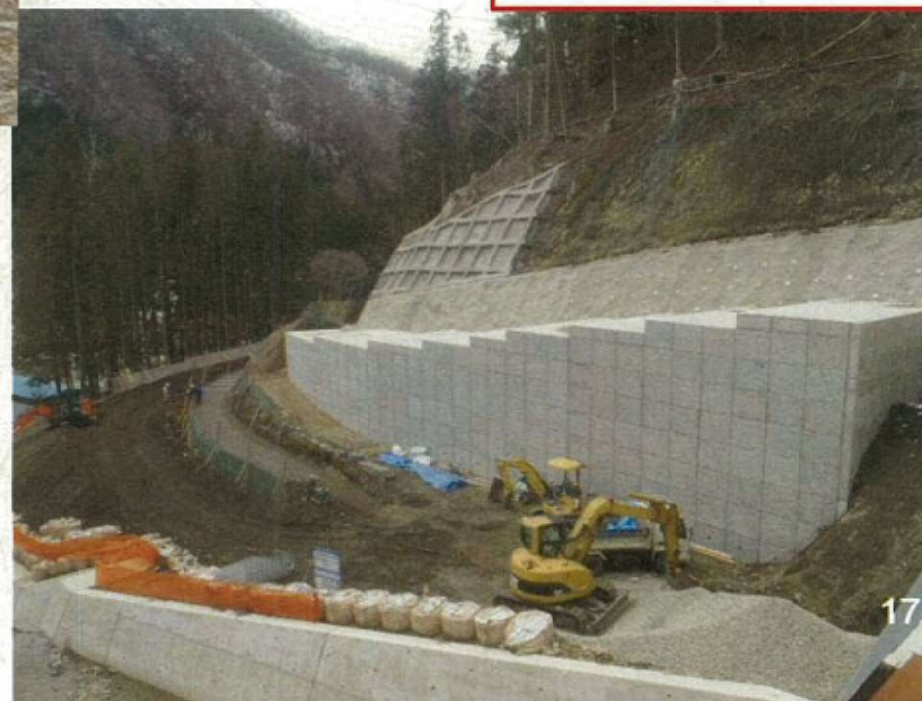
軽量盛土擁壁工 (中坪下沢)
