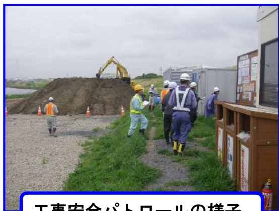
工事安全パトロールの様子
