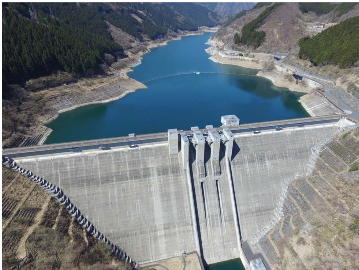
滝沢ダム(平成31年4月16日撮影)
