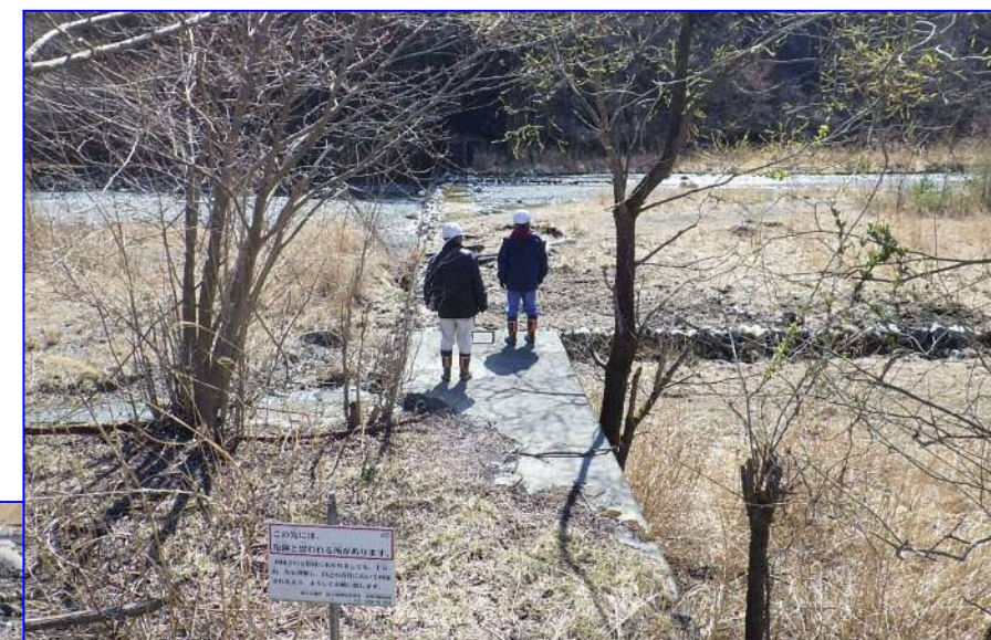
釜無川上流域の点検状況▲
