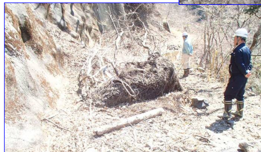
▲早川流域の点検状況
