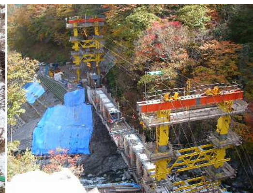
【もうすぐ架設完了】
