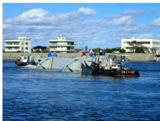
【予備ゲート曳航中！】
