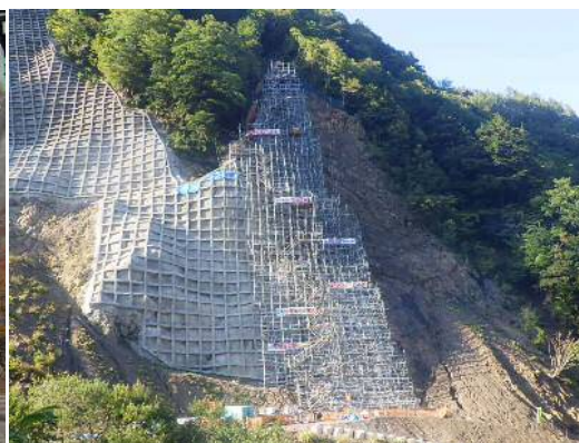
【鉄筋挿入工・仮設足場組立】
