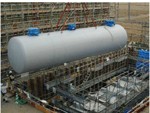
【地中埋設される地下燃料貯油槽(70KL)】
