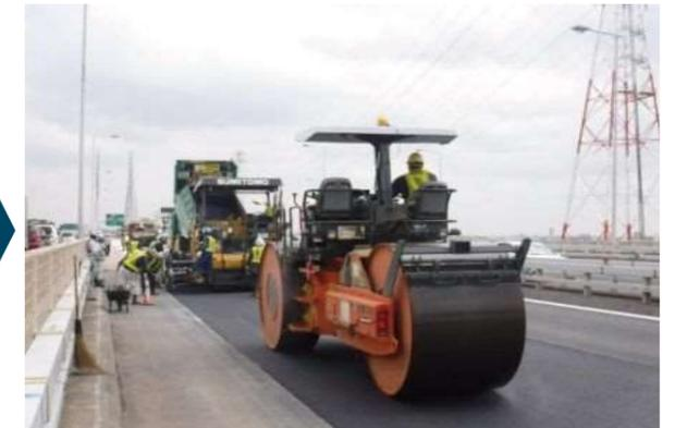
その後、コンクリート上にアスファルト舗装を施工し、路面を仕上げます。
