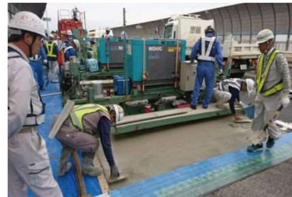
通常ならば、表面の舗装を撤去した後、鋼床版の上ですぐアスファルト舗装を施工しますが、リニューアル事業では、橋梁の長寿命化を図るため、剛性の高いコンクリート(SFRC:鋼繊維補強コンクリート)をまず施工します。
