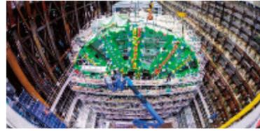
断面直径が16mにもなる国内最大級のシールドマンシンの組み立て(大泉JCT) 平成30年7月4日撮影
