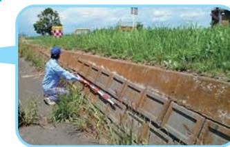
※3 堤脚保護工の変形
