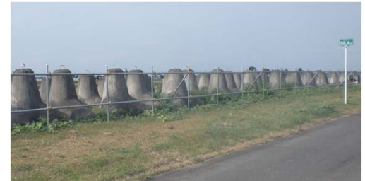
根固めブロックの備蓄
