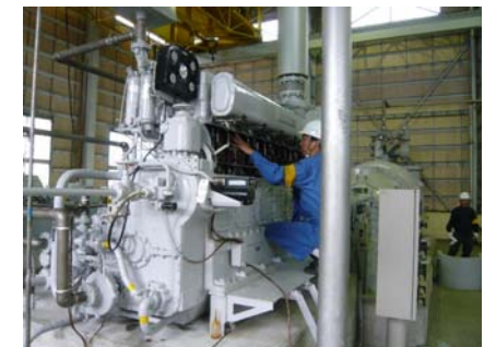
排水機場ポンプの修繕
