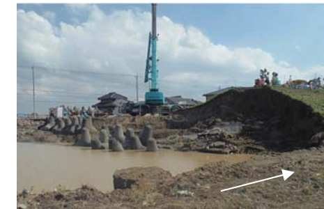
鬼怒川決壊地点の災害復旧工事状況 (平成27年関東・東北豪雨時)
