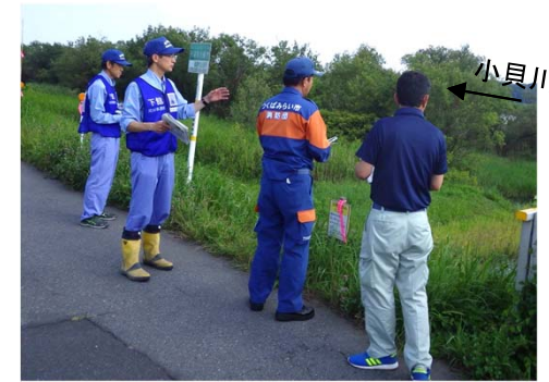
市町職員、消防団との共同点検 (重要水防箇所)
