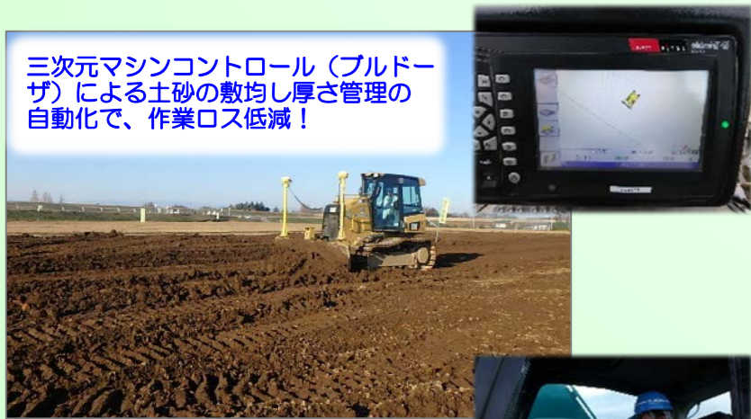
GNSS（全球測位衛星システム）による盛土の締固め管理により、施工結果の自動的な判定ができ、作業効率アップ！
