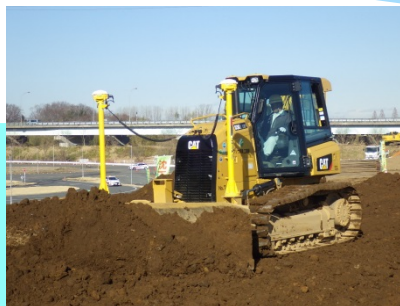
MCブルドーザによる敷均し
