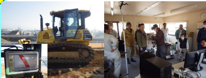
盛土の締固め結果の表示画面
