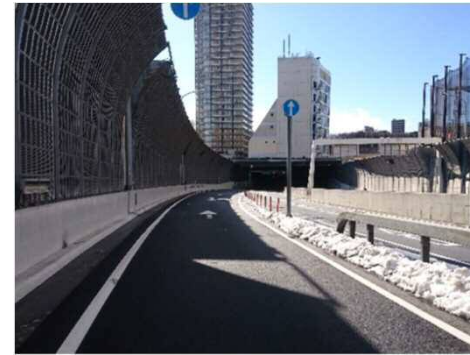
◎高速道路の除雪状況(首都高)
