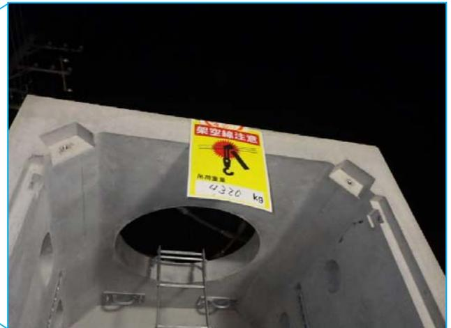
✓ 作業状況によっては、のぼり旗による注意標示がオペレーターから視認しにくくなることから、従来ののぼり旗の設置による架空線等の損傷防止対策に加え、吊り上げ資材のオペレーターから視認しやすい箇所に、架空線注意の標示を設置することで架空線損傷事故を防止。
