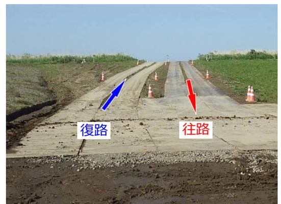
✓ 工事用道路を往路・復路で別々に設置し、**一方通行ルールを定めることでダンプ同士の接触を防止**するとともに、工事現場内の混雑を防止。
