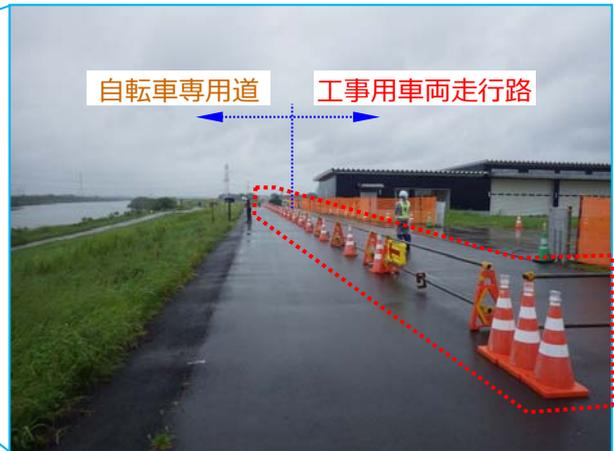
✓ 工事関係車両が走行するルートの一部が、自転車専用道と交差することから、単管バリケード及びカラーコーンにより明確な分離措置を実施し、**錯綜による第三者との接触事故を防止**
