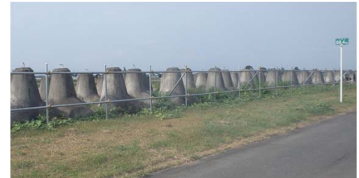
根固めブロックの備蓄
