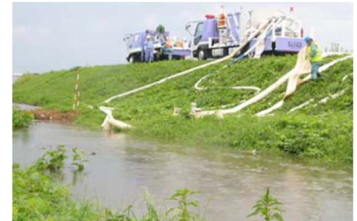
排水ポンプ車による内水氾濫箇所からの排除
