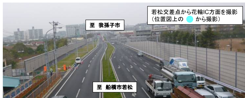
4車線化後の県道船橋我孫子線若松交差点付近
