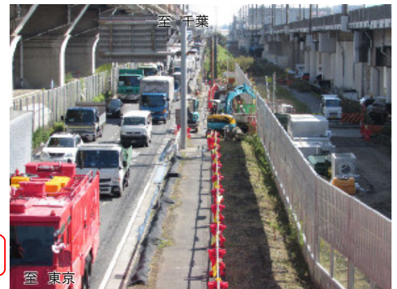
③ 栄町交差点改良状況
