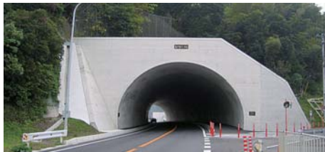
島戸倉トンネル
