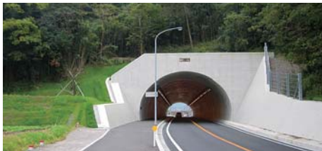
勝岩トンネル
