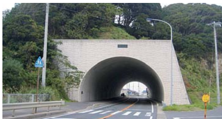
打越トンネル
