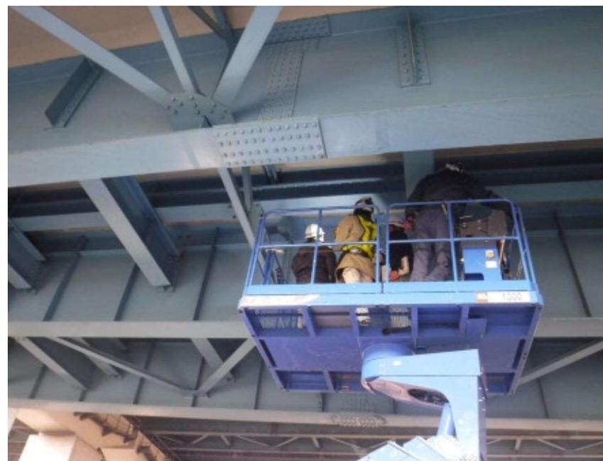
高所作業車を用いた近接目視点検
