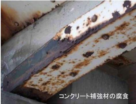
コンクリート補強材の腐食
