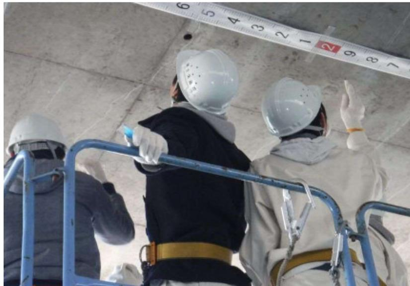
高所作業車を用いた近接目視点検
