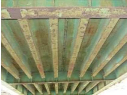
桁下部(主桁・縦桁・横桁・鋼床版)の腐食
