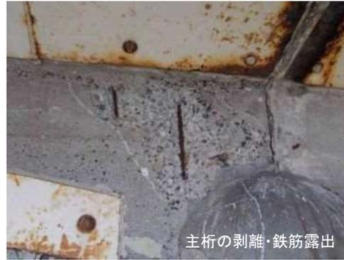
主桁の剥離・鉄筋露出
