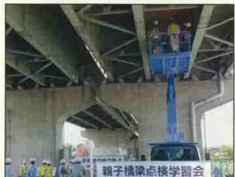
高所作業車に乗って、橋の裏側を点検
