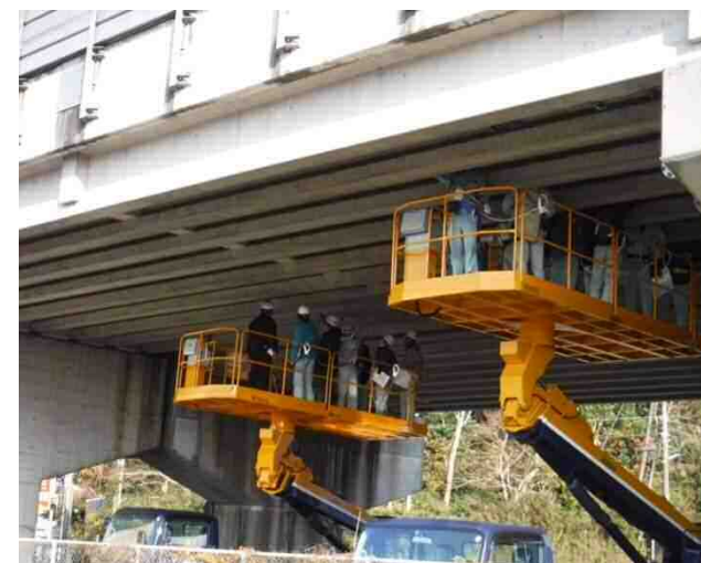
（橋梁研修等の実施状況）
