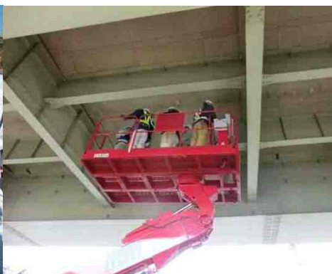
<近接目視点検>
