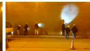
点検実習(打音点検・クラック調査)
