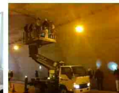
高所作業車による近接点検
