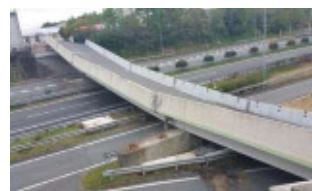
写真-1 県道小川嘉島線 府領第一橋
