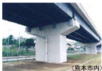
写真-3 国道3号 跨線部
