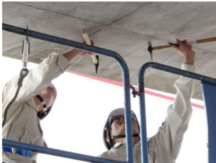
高所作業車を用いた近接目視点検
