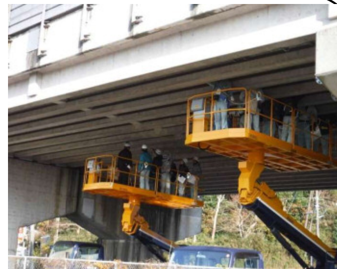
（橋梁研修等の実施状況）
