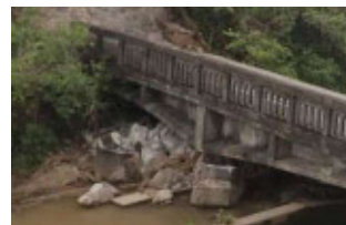
写真-2 平田・小柳線 田中橋
