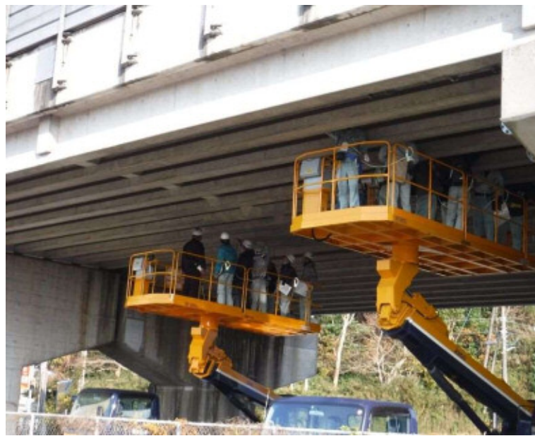
高所作業車を用いた近接目視点検
