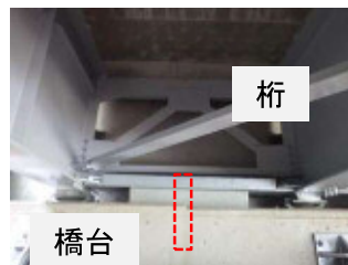
写真-5 アンカーバー のイメージ
