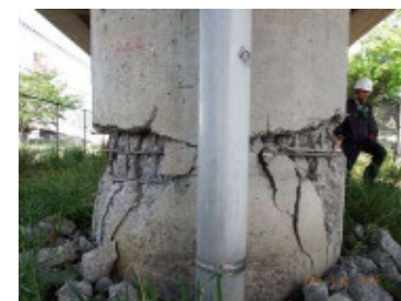
写真-7 段落し部の損傷 ちゅうおうせんりっきょう 市道(1-3)中央線・中央線陸橋
