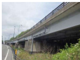
写真-4 阿蘇口大橋 (国道57号)
