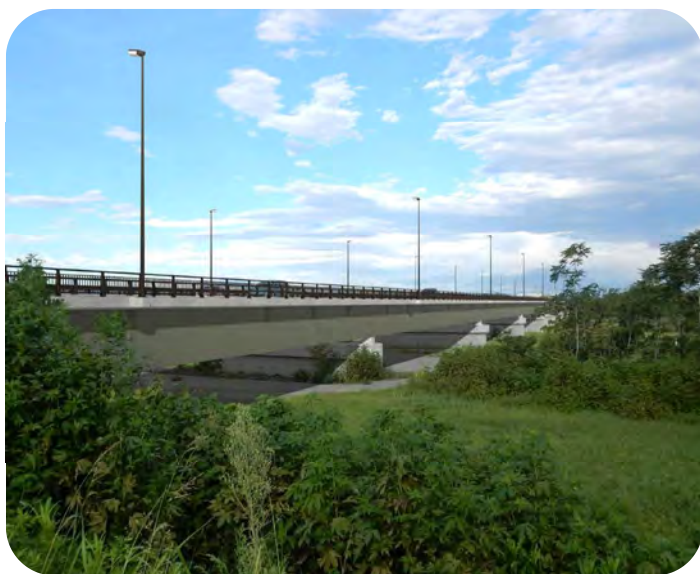
本庄道路 神流川橋 (新橋)
