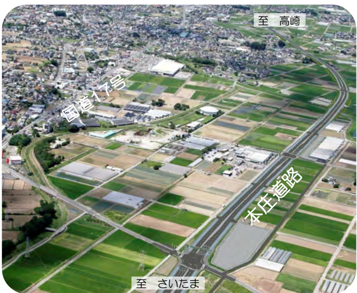
本庄道路 土工部
