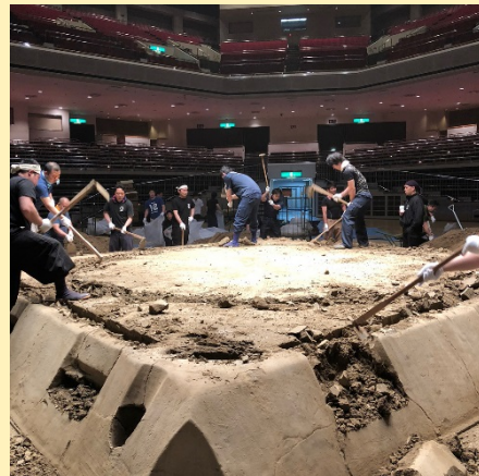
両国国技館での土俵築の様子
