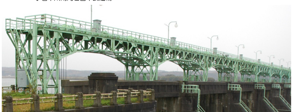
大河津可動堰
