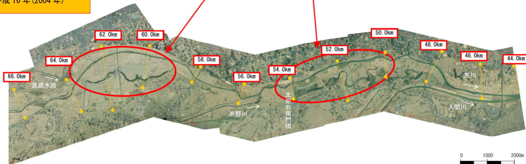
図 1-5 (1) 荒川空中写真 (44~66km)
