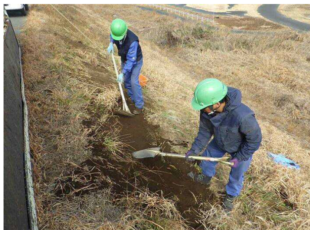
堤防法面の簡易補修実施状況（イノシシの掘り返し被害箇所の補修）
