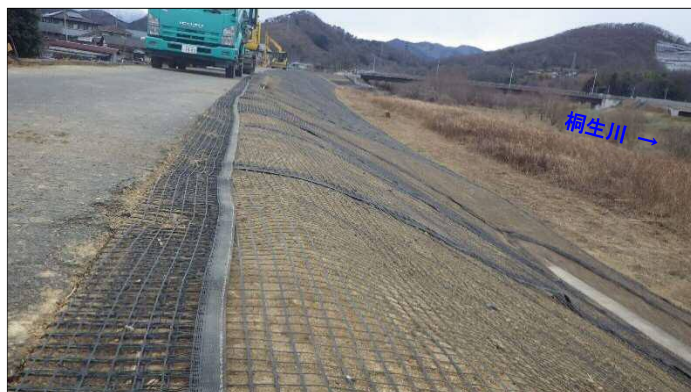
補強シートの設置状況（この上に芝を張ります）
