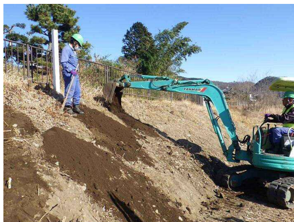
堤防法面の簡易補修実施状況（イノシシの掘り返し被害箇所の補修）
