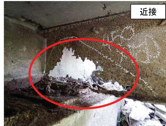
近接目視により断面欠損を確認
