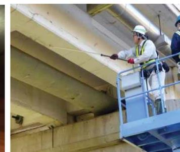
▲コンクリートのうき・はく離を非破壊で検査する技術
