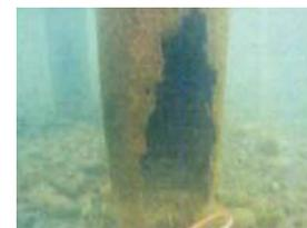
▲橋脚水中部の断面欠損
