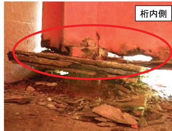
桁内側からの近接目視により断面欠損を確認
