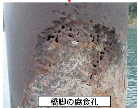
橋脚の腐食孔
