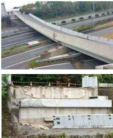
写真-2 横変位拘束構造の破壊、落橋
