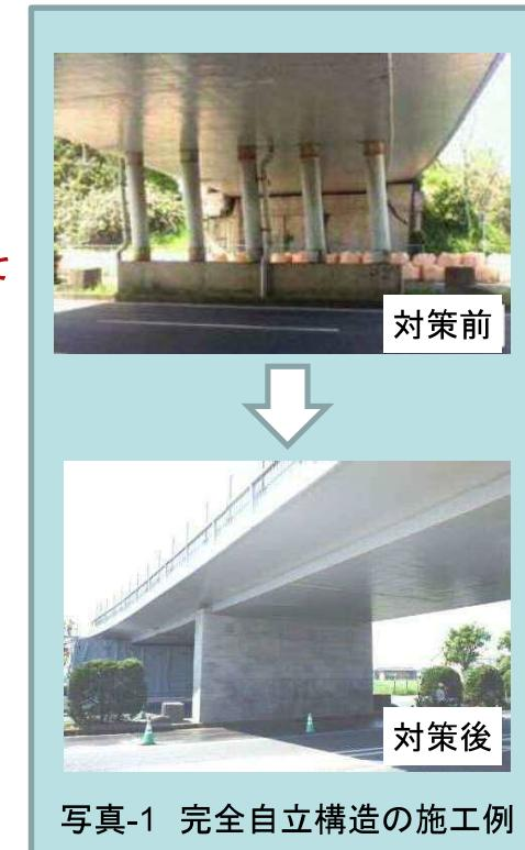
写真-1 完全自立構造の施工例
