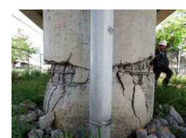
写真-7 段落し部の損傷
