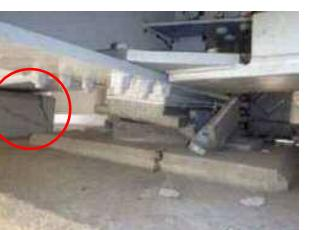
写真-6 支承の破損の状況
