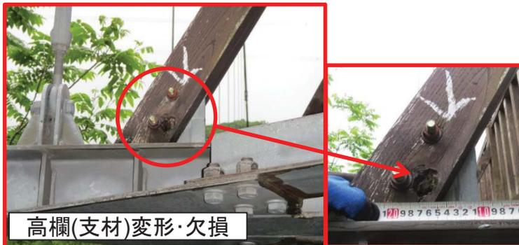
高欄(支材)変形・欠損
