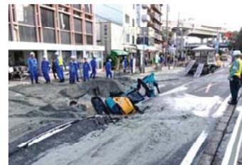
埋設管の老朽化に伴う道路陥没
