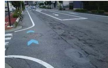
占用工事が起因する路面損傷
