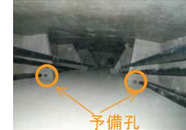
新設橋にて、ケーブル交換、追加用の予備孔を設置
