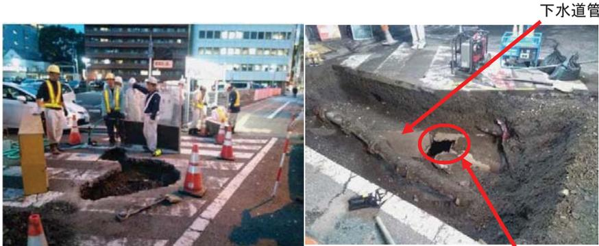
路面陥没 約1.7m×2.6m×0.6m(深さ)
