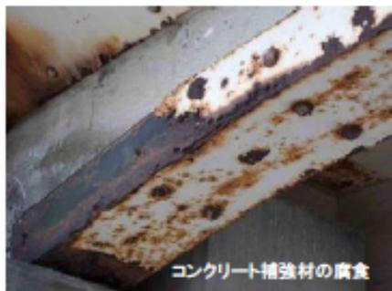
コンクリート補強材の腐食
