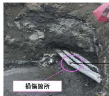
既設ケーブルが、予定されていた位置からずれて埋設されていたため、掘削時に損傷が発生
