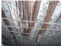
PC鋼材の腐食例
