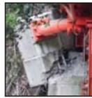
制震ダンパー取付部の損傷により、制震ダンパーが機能しない事例が存在したため、部材接合部について留意する必要
