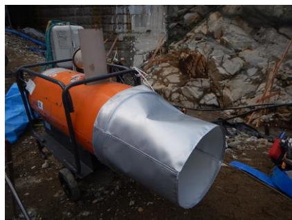
ジェットヒーターによるコンクリート養生 ※H31.1.23時点の情報です。
