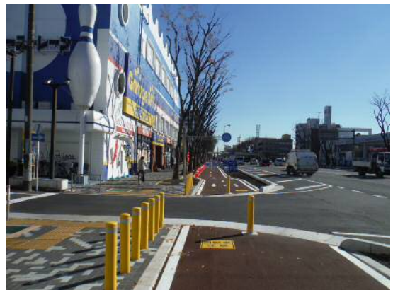
自転車道完成後
