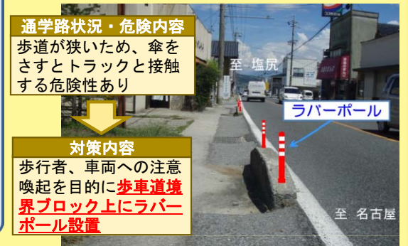
飯田市内における安全対策工事 (イメージ)
