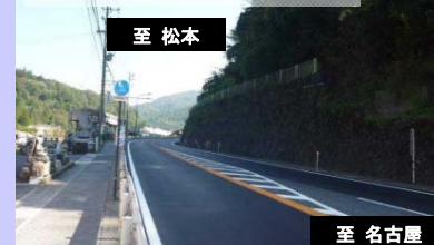
名古屋側から当該区間を望む
