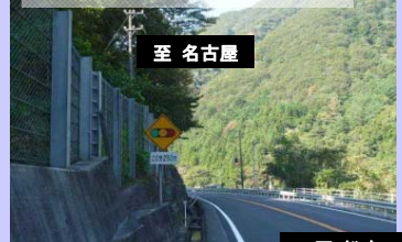
松本側から当該区間を望む
