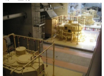
4台のポンプで、25mプールの水を約1秒で排水（最大200m 3 /s）
