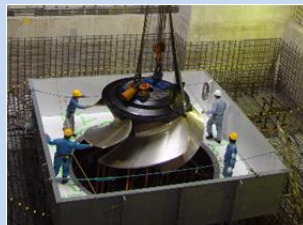
排水ポンプの羽根車設置
