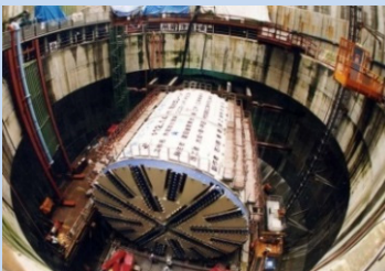
シールドマシンによるトンネル工事
