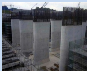
調圧水槽の建設工事
