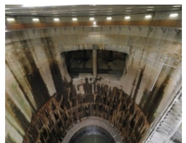
内径最大31.6m、深さ70mの縦穴第一立坑
