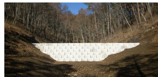
コンクリートブロックによる不透過型砂防堰堤の施工事例 国土交通省 関東地方整備局 利根川水系砂防事務所管内 船ヶ沢川
