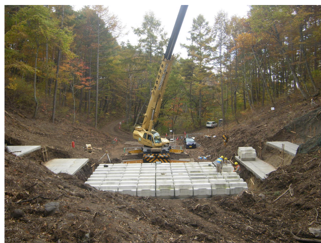
船ヶ沢川西砂防堰堤の施工状況
