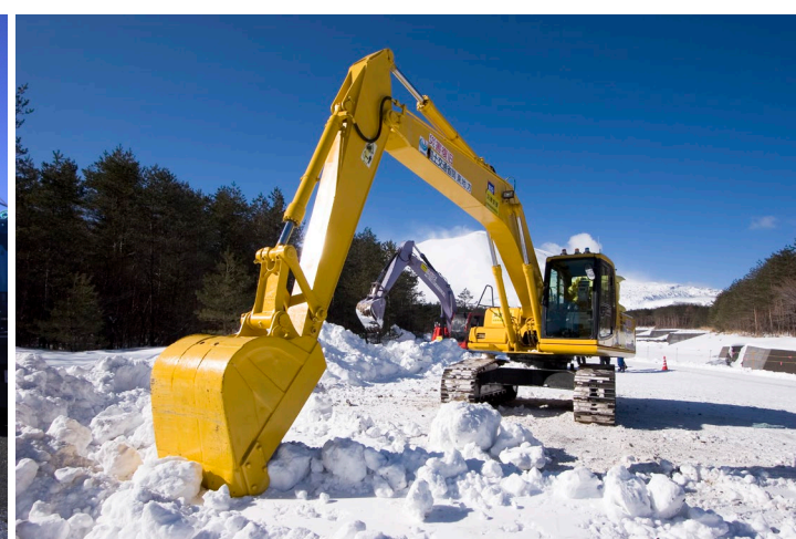
無人化施工による掘削試験
