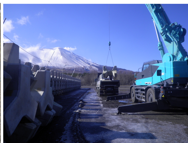
濁沢 据付工事状況
