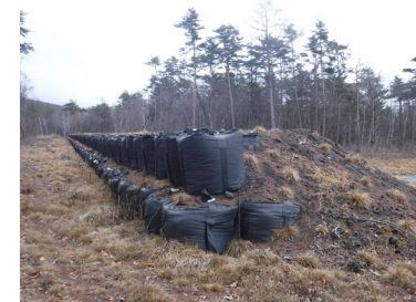
図 大型土のうによる導流工の施工事例 国土交通省 関東地方整備局 利根川水系砂防事務所管内 大日向第2砂防堰堤
