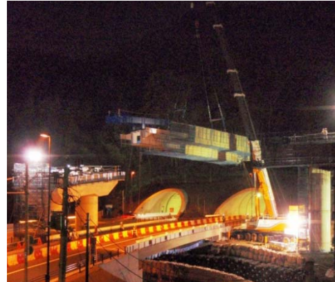
橋梁の架設状況
