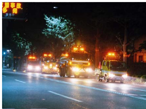
路面清掃状況
