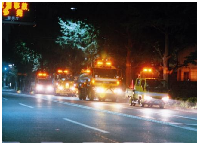
路面清掃状況
