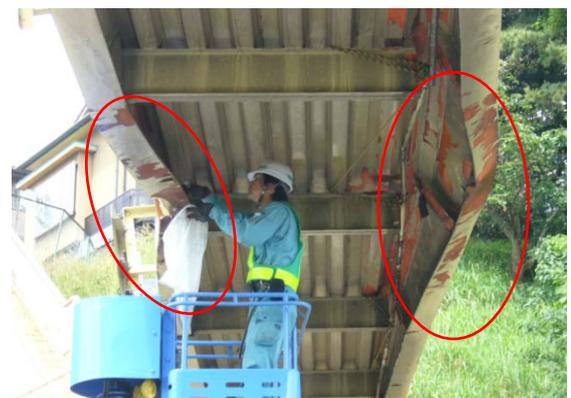
積荷が歩道橋に接触し変形
