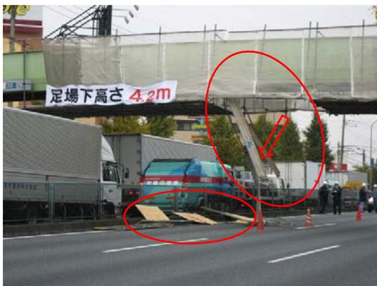
積荷が歩道橋の仮設足場に接触し崩落
