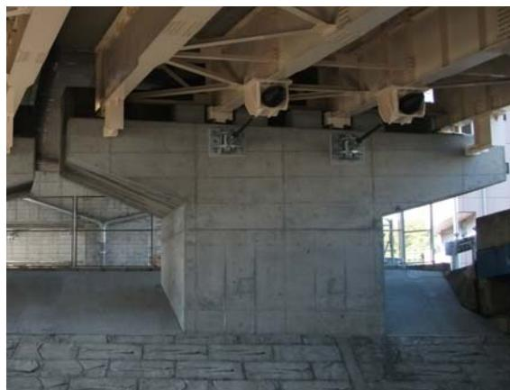
耐震補強（橋脚Co巻立て補強、落橋防止装置）事例
