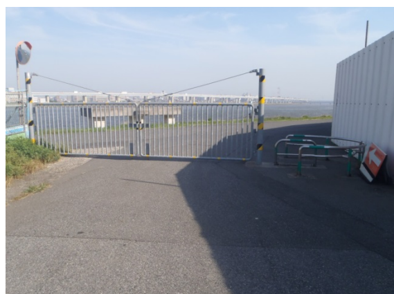
荒川ロックゲート進入口 (10:00 集合場所)
