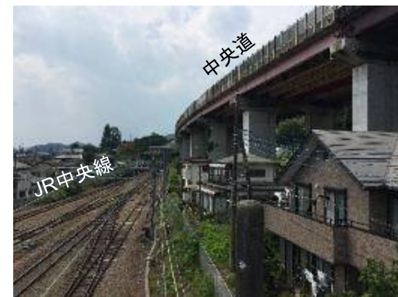
〔 対策を実施する相模湖高架橋 〕
