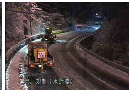
凍結防止剤散布作業状況
