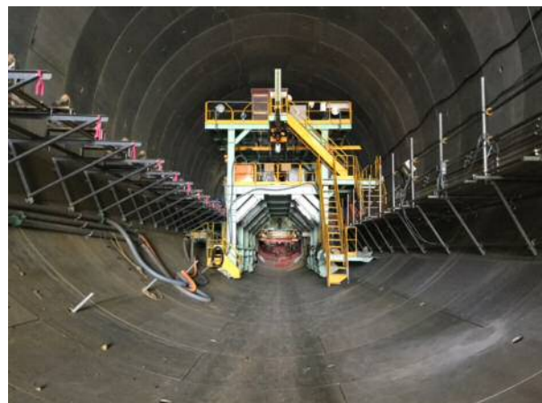
国道20号八王子南BP (仮称)館第一トンネル坑内様子
