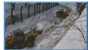
ホイールローダーによる除雪状況
