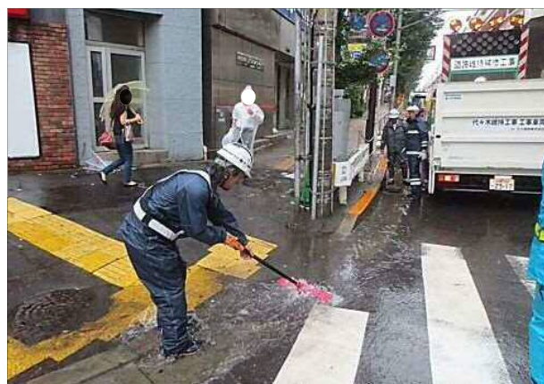
③溜まった雨水を排水溝へ流す緊急作業
