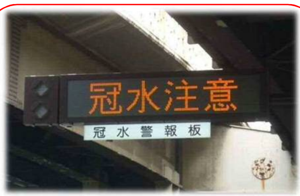
冠水時には電光掲示板で注意喚起を行います
