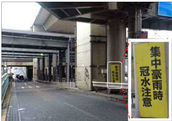
②豪雨時の走行注意喚起の標識設置
