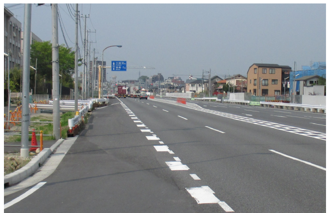
小荷田交差点付近の状況 (平成27年4月撮影)
