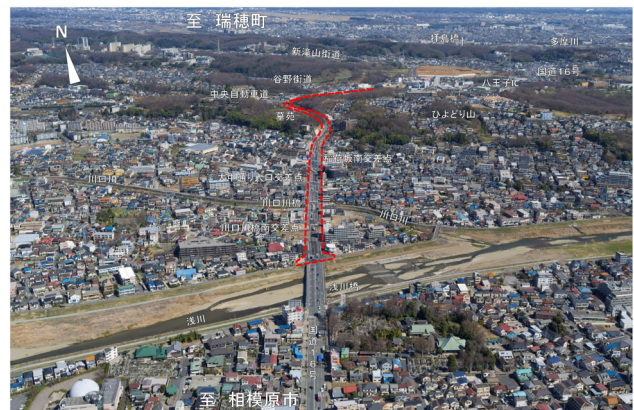
浅川橋から川口川橋方面を望む (平成27年3月撮影)
