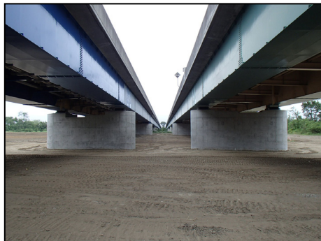
耐震補強（橋脚コンクリート巻き立て補強、免震支承への取替）事例 *写真は国道16号拝島橋のうち、工事が完成した箇所のもの
