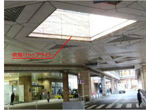
写真: 府中駅南口デッキの採光確保のための吹抜けトップライト
