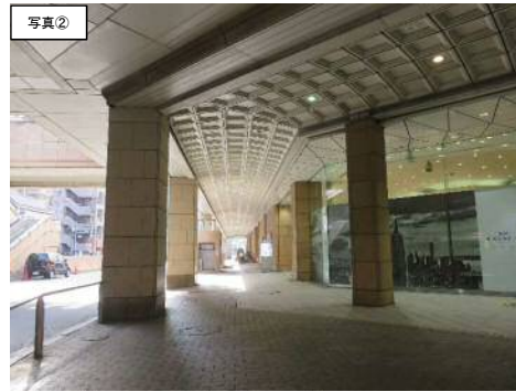
写真: 府中駅南口デッキと商業施設の接続部の橋脚配置
