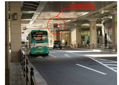
写真: 府中駅南口デッキ下の信号灯機
