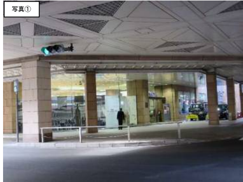
写真: 府中駅南口デッキと商業施設の接続部の橋脚配置
