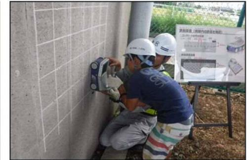
鉄筋探査機で鉄筋の位置を確認
