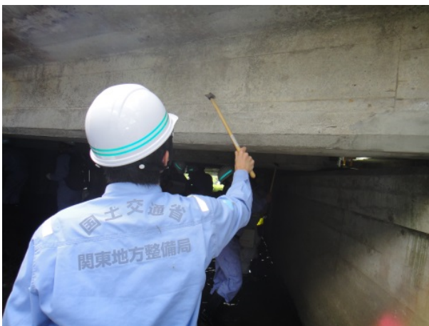
橋梁点検状況
