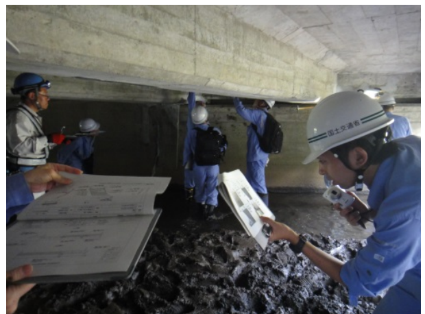
橋梁点検状況
