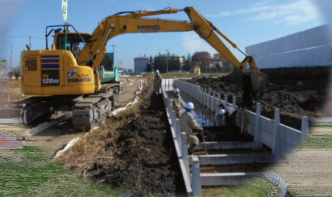
水路施工状況
