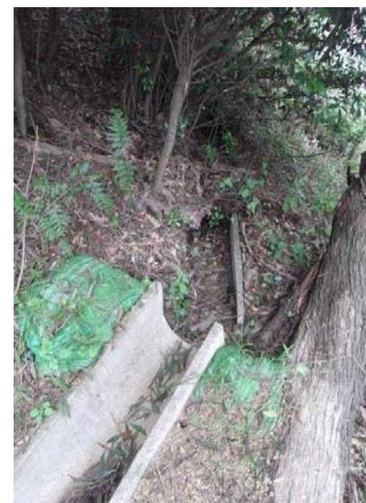
写真 排水溝の破損の例
