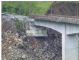
斜面変状による橋台の沈下
