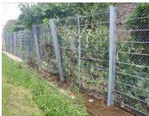
写真 落石防護柵の傾動の例
