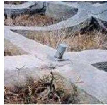
写真 受圧構造物の破損の例
