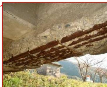
主桁の剥離、鉄筋露出
