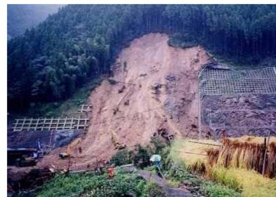
強風化・土砂化斜面での崩壊例
