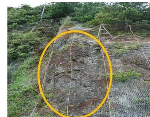
写真 落石防護網の著しい腐食による断面欠損の例
