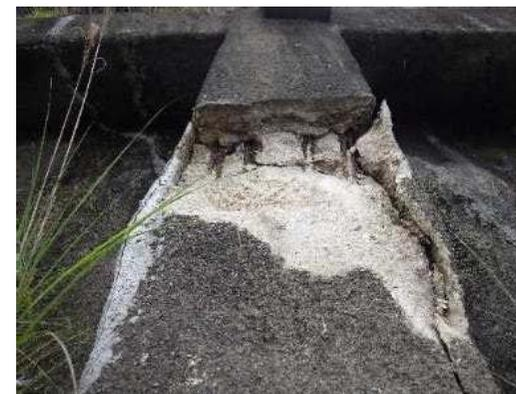
法枠工の老朽化損傷
