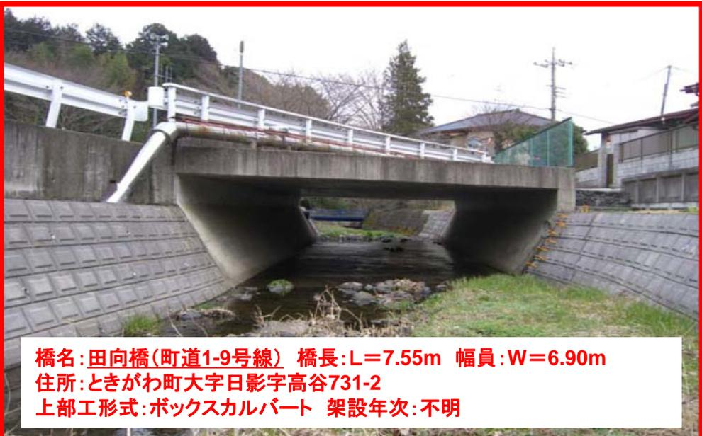
橋名:田向橋(町道1-9号線) 橋長:L=7.55m 幅員:W=6.90m
